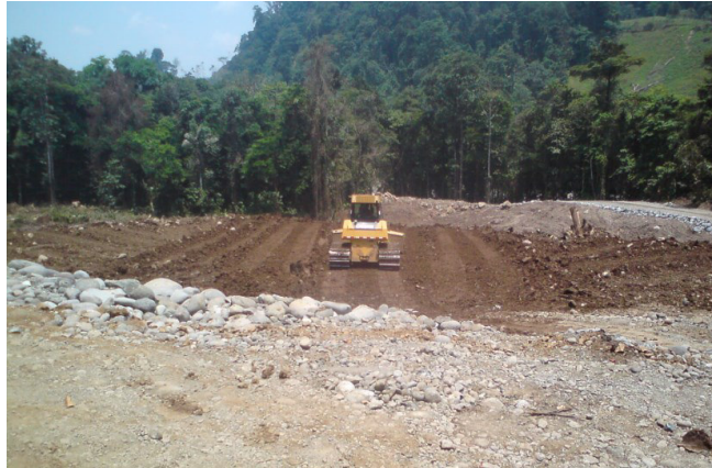
Figura n° 5. 37 Acomodo material escombrera 15 PH. Reventazón. Fuente: ICE, 2017.
