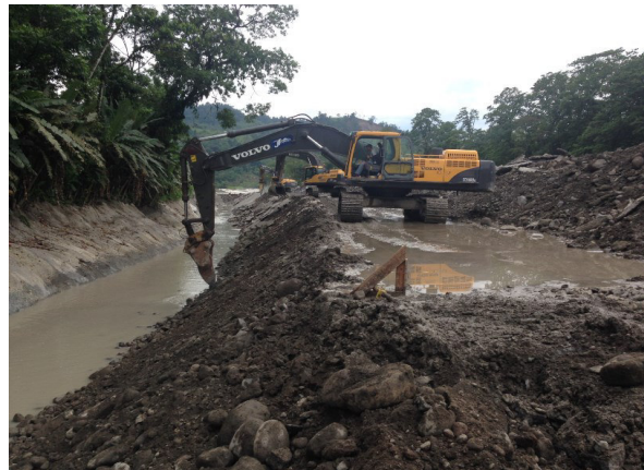
Figura n° 5. 40 Excavación canal derivación PH Reventazón. Fuente: ICE, 2017.
