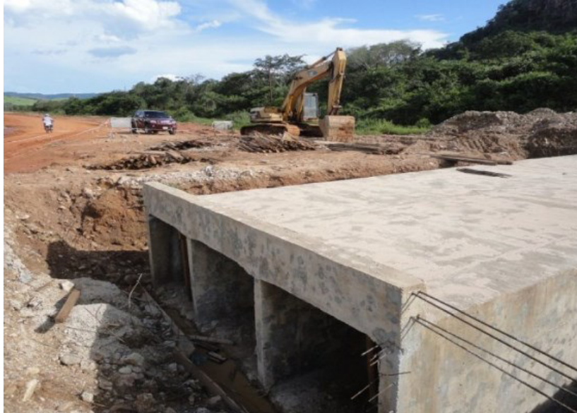
Figura n° 5. 46 Excavación típica sifón. Fuente: Imagen tomada de internet, 2017.
