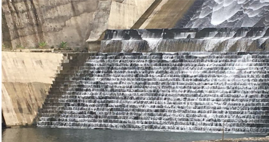
Figura n° 5. 31 Estructura disipadora vertedero PH Reventazón. Fuente: ICE, 2017.
