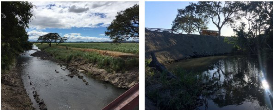
Figura n° 8. 41. Alteración del cauce del Río Liberia. Arriba cauce previo a la construcción del dique de la fotografía de abajo.
