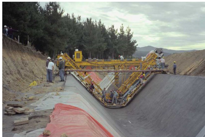
Figura n° 5. 52 Encofrado deslizante para canales secundarios. Fuente: Imagen tomada de Internet, 2017.
