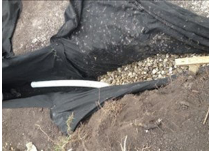
Figura n° 5. 35 Filtros piedra y geotextil para escombreras.
