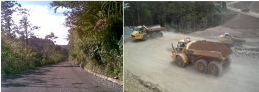
Figura n° 5. 4 Caminos de obra, P.H. Reventazón.
