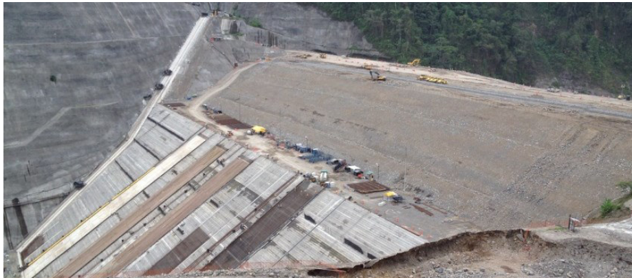
Figura n° 5. 16 Bordillo rellenos de Presa PH Reventazón. Fuente: ICE, 2017.
