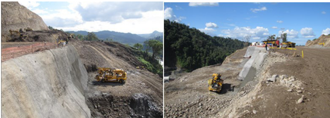
Figura n° 5. 29 Excavación y Estabilización Vertedor PH Reventazón
