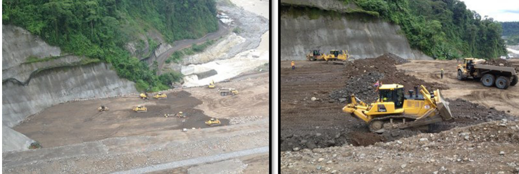
Figura n° 5. 15 Proceso de colocación de rellenos presa PH Reventazón. Fuente: ICE, 2017.
