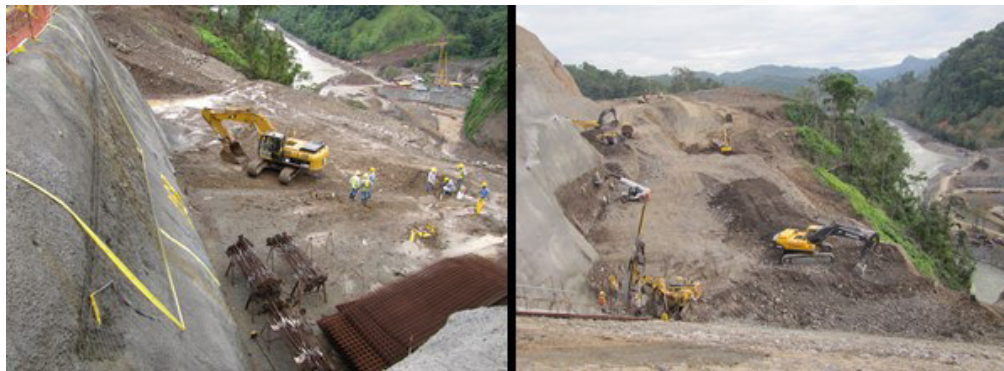
Figura n° 5. 14 Estabilización MD Presa PH Reventazón. Fuente: ICE, 2017.
