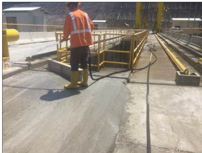
Figura n° 5. 30 Puente Vertedor PH Reventazón Fuente: ICE, 2017.
