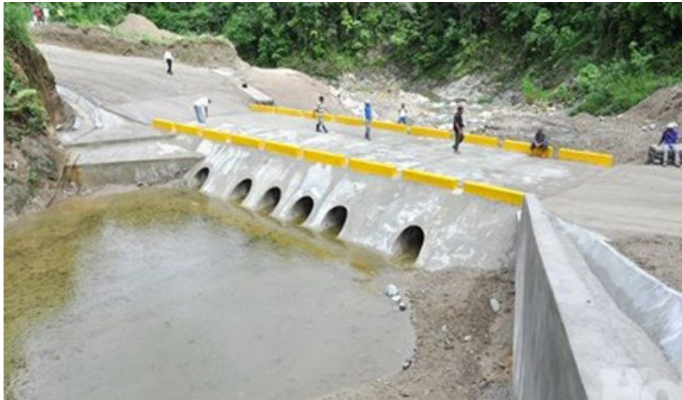
Figura n° 5. 7 Ejemplo paso alcantarillado por río.
