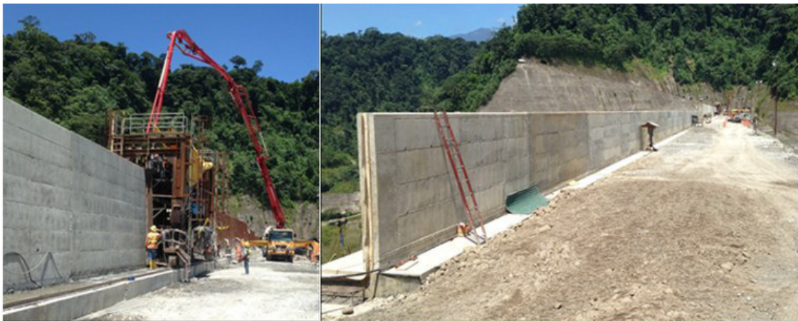
Figura n° 5. 25 Colocación de concreto módulos Parapeto, Presa P.H.R. Fuente: ICE, 2017.
