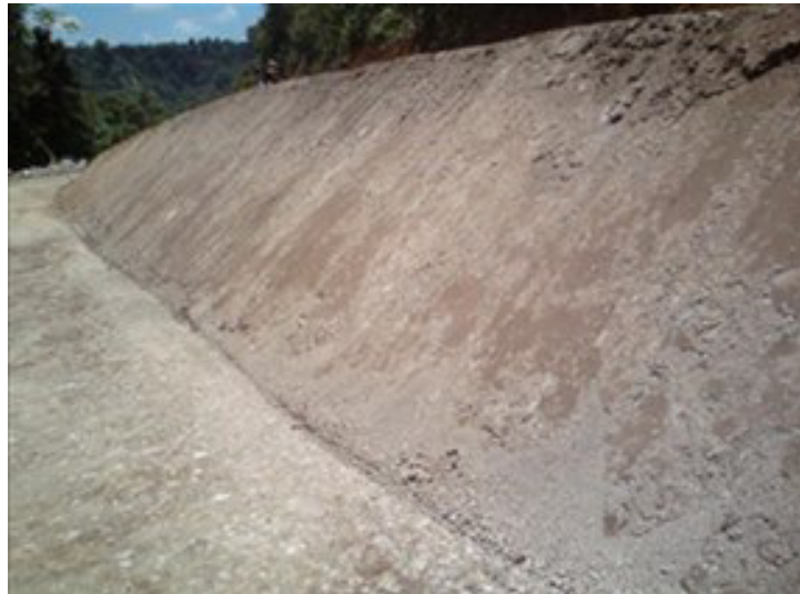
Figura n° 5. 36 Diques retención con materiales de excavación.
