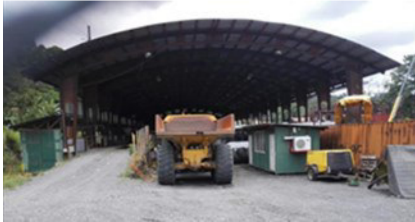
Figura 59. Talleres PH Reventazón Fuente: Construcción-PAACUME, 2017.
