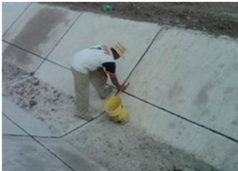
Figura n° 5. 43 Relleno típico de juntas con emulsión asfáltica.
