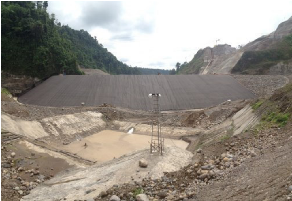
Figura n° 5. 11 Ataguía P.H. Reventazón Fuente: ICE, 2017.
