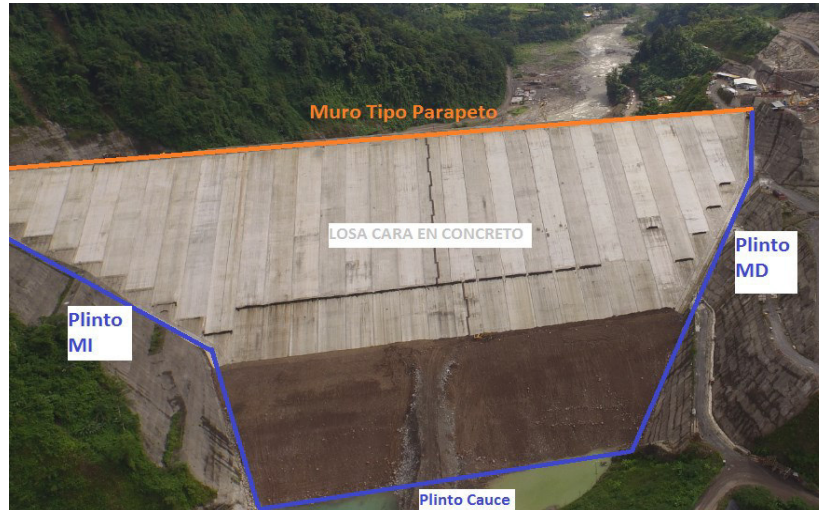
Figura n° 5. 17 Imagen Obras Civiles Presa, P.H. Reventazón. Fuente: ICE, 2017.
