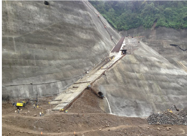
Figura n° 5. 19 Excavación y construcción sello plinto margen izquierda PH Reventazón. Fuente: ICE, 2017.
