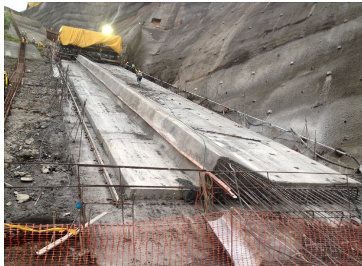
Figura n° 5. 22 Deslizado plinto margen derecha PH Reventazón. Fuente: ICE, 2017.
