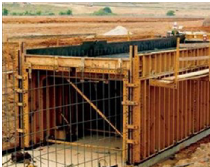
Figura n° 5. 47 Sifón colado en sitio. Fuente: Imagen tomada de Internet, 2017.
