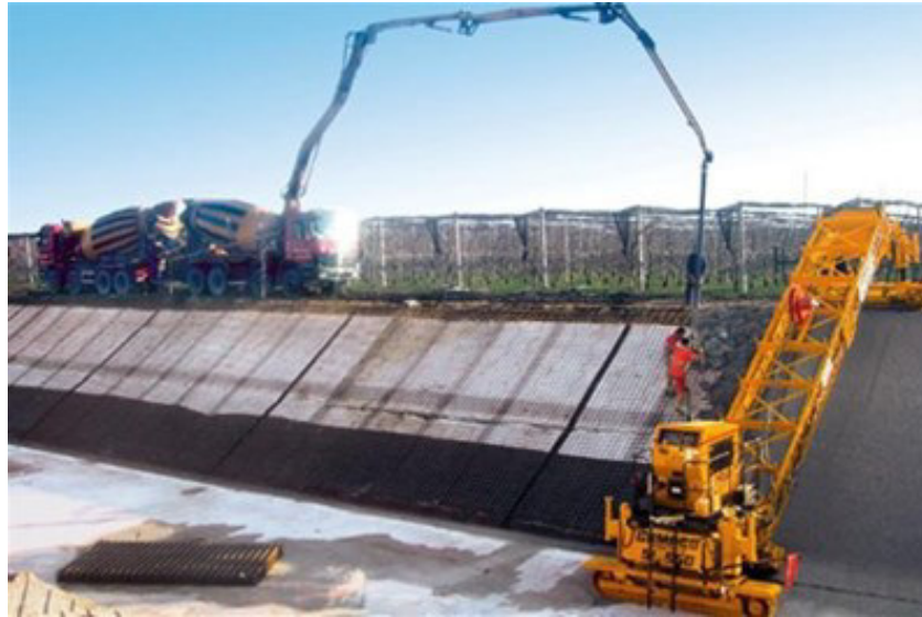
Figura n° 5. 42 Proceso de colocación de acero y revestimiento en canales con encofrado deslizante.
