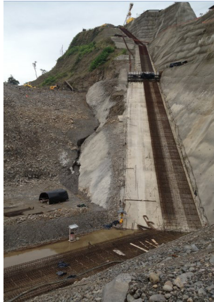
Figura n° 5. 21 Acero plinto margen derecha PH Reventazón. Fuente: ICE, 2017.
