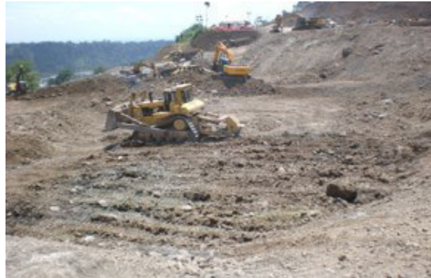
Figura n° 5. 13 Excavación MD Presa PH Reventazón Fuente: ICE, 2017.
