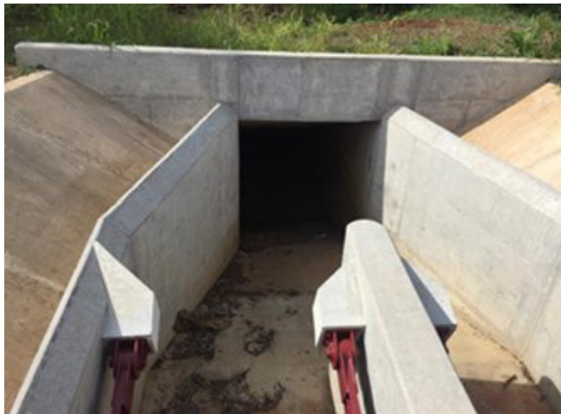
Figura n° 5. 45 Sifón Canal Sur SENARA. Fuente: SENARA, 2017.
