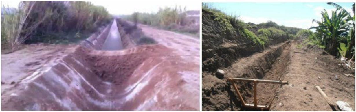
Figura n° 5. 51 Excavación canales secundarios Fuente: Imagen tomada de Internet, 2017.
