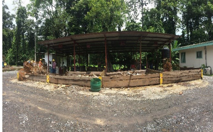
Figura n° 5. 64 Sitio de transferencia de residuos en frente de obra.
