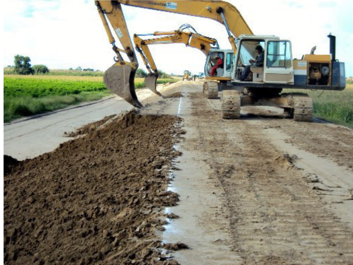
Figura n° 5. 41 Conformación talud de relleno dique compactado en canales Fuente: Imagen tomada de Internet, 2017.
