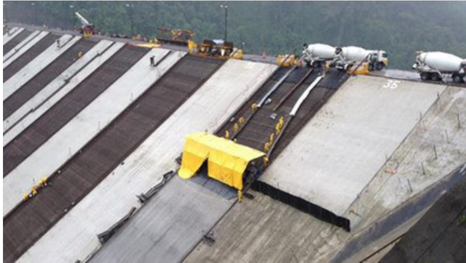
Figura n° 5. 24 Colocación de concreto losa 34, Cara de concreto, Presa P.H.R. Fuente: ICE, 2017.
